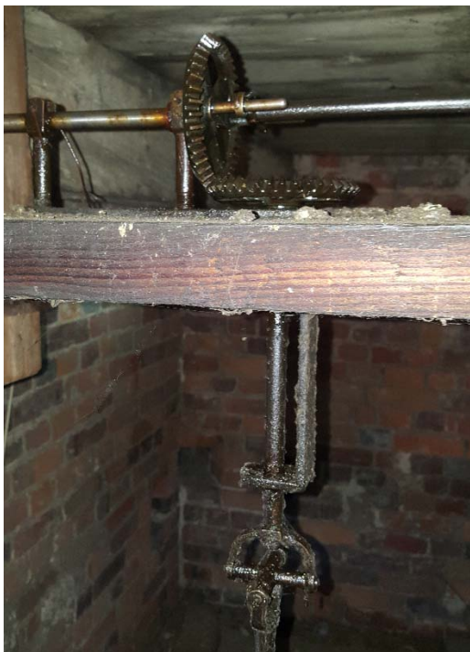
Foto napojení rozvodu od mechanického stroje na rozvod k jednomu z číselníků. Patrný je i kloub.
